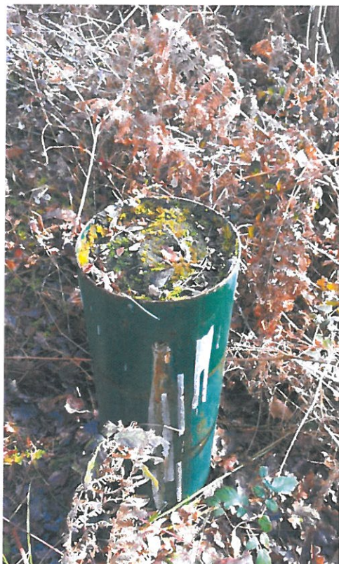
Photographie 4 : Tête de protection cimentée du piézomètre P3
