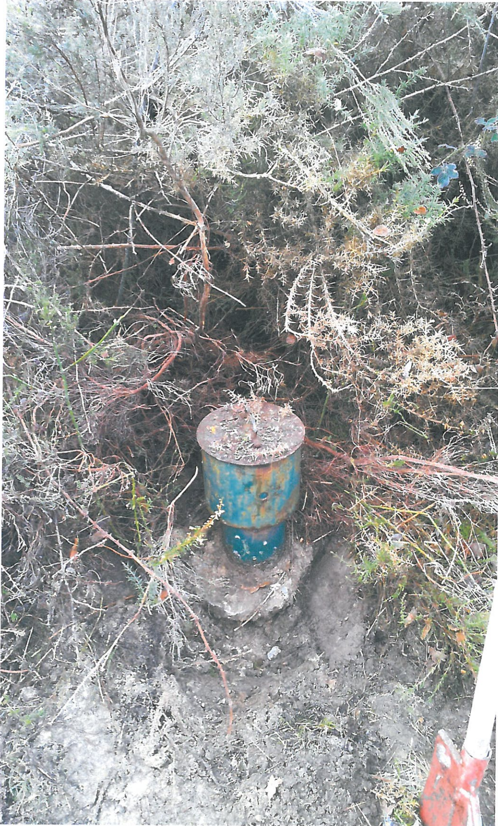
Photographie 1 : Capot de protection du piézomètre URS3 avant comblement
